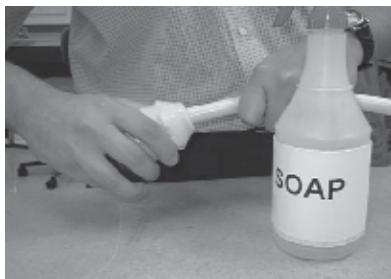
2. Aplique en la terminación de la manga una solución a base de jabón e inviértalo, tirando para ello el final del cable en contra del final de la manga. Empuje el cable por aproximadamente 12" [pulgadas] a través de la manga.
